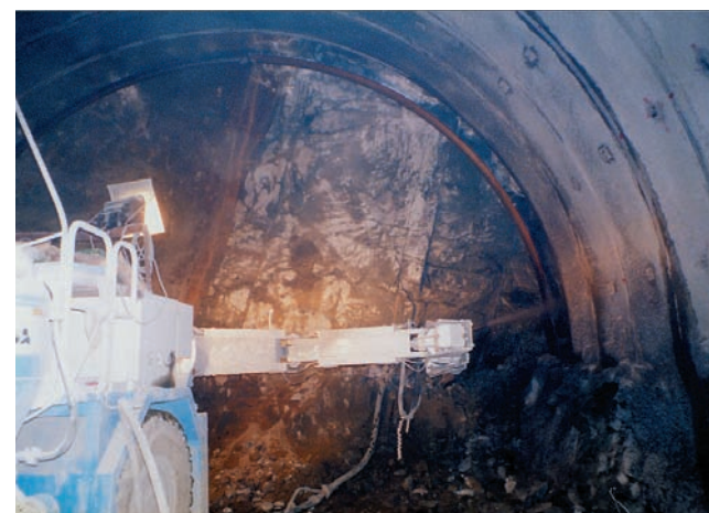
道路トンネルでの吹付け状況
