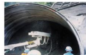
EPショット（トンネル吹付）
