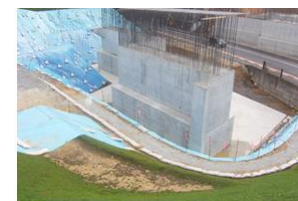
高規格道路橋脚
